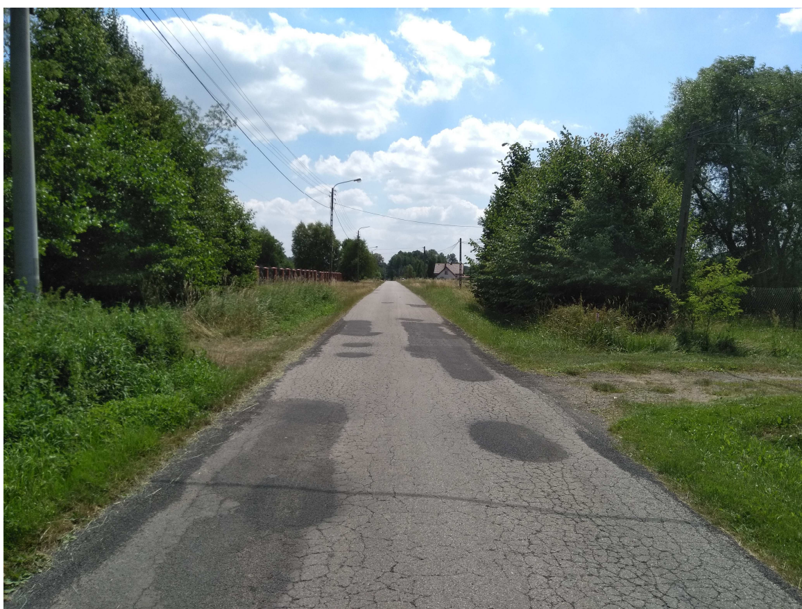
Zd.2. Spękania siatkowe na łatach wykonanych podczas remontów częściowych.
