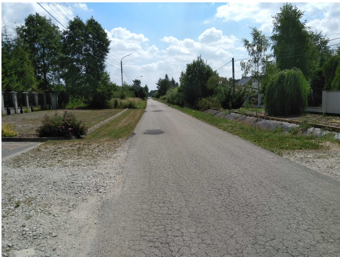
Zd.1. Widok na liczne duże spękanie nawierzchni powierzchniowo utrwalonej.
